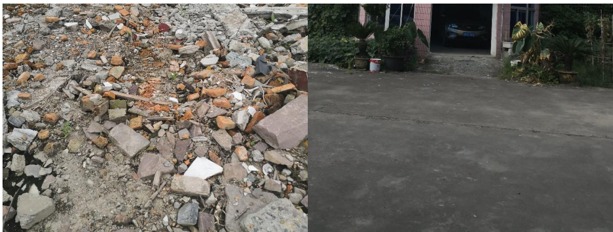
图 2.5-1 HS07-04-03b 场地地面现状照片
