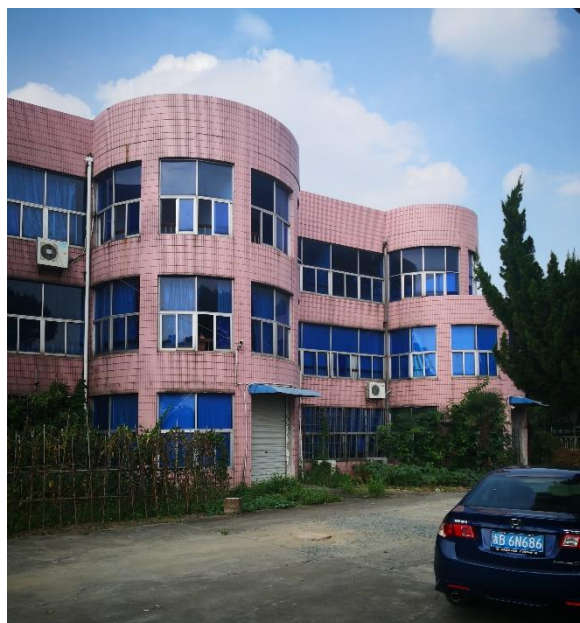
场地东北角段塘村拆迁办办公场地
