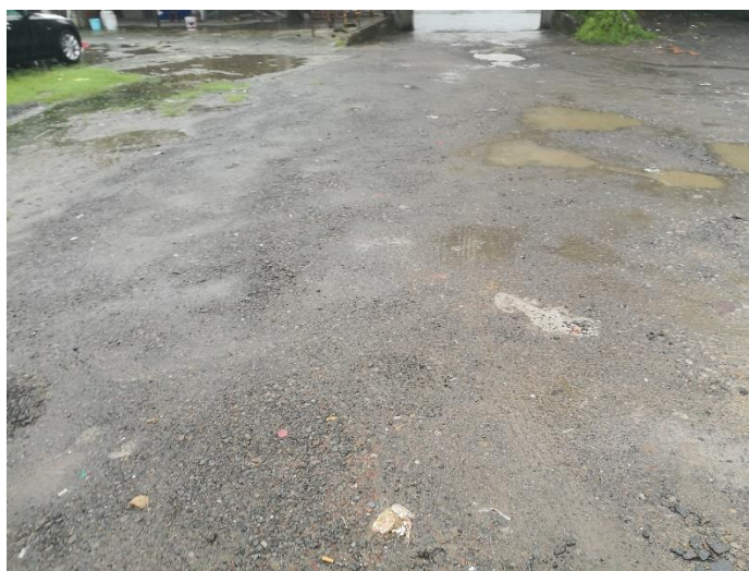
图 2.5-2 HS07-04-06 场地地面现状照片
