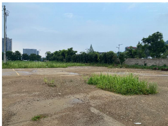
水泥硬化地面（驾校练车场地）
