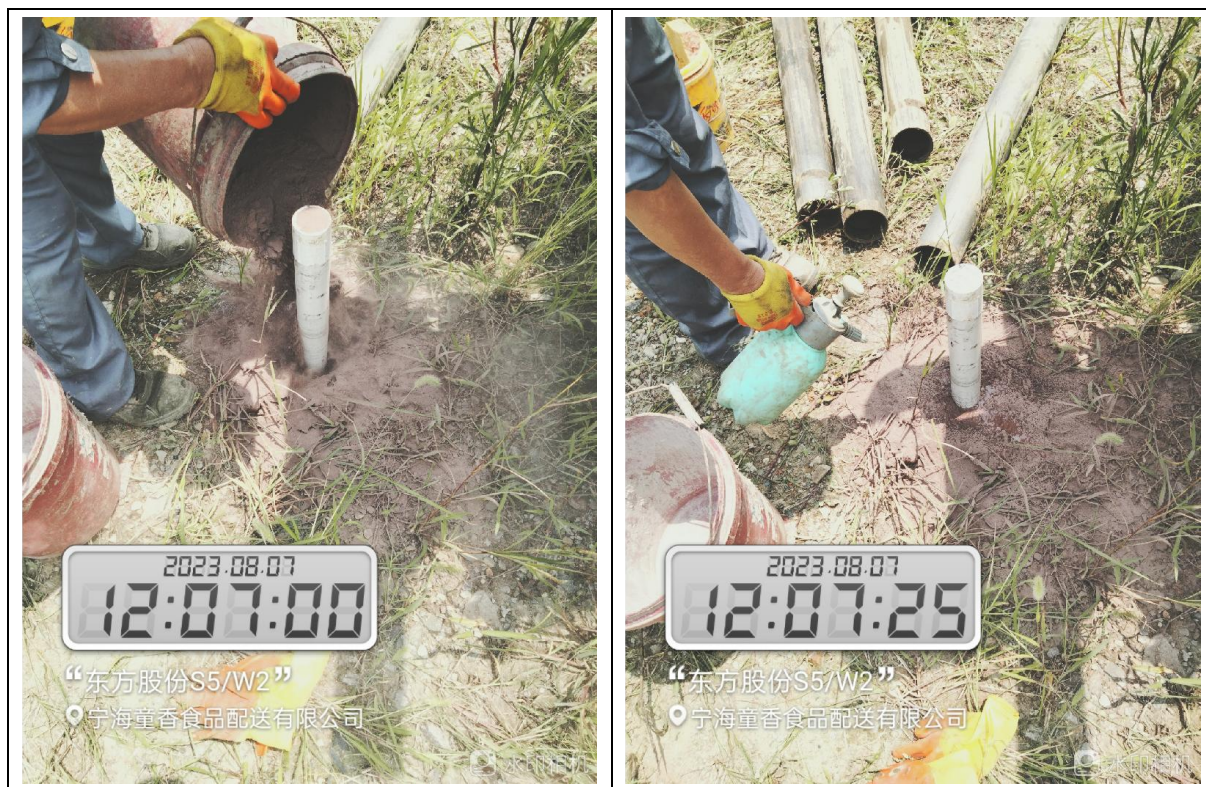
图 3.3-7 密封止水照片
