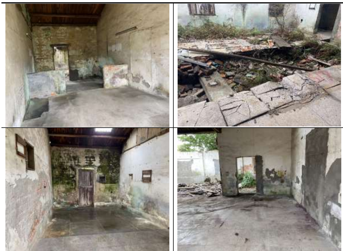
车间内地面情况
