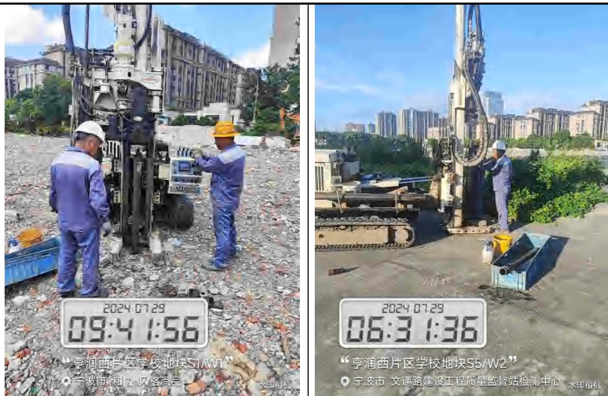
图 5.2-5 地下水监测井钻孔照片
