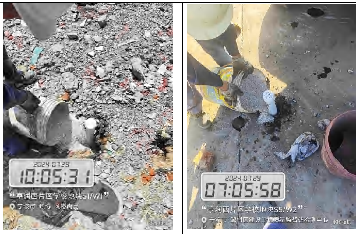
图 5.2-7 地下水监测井填充滤料照片
