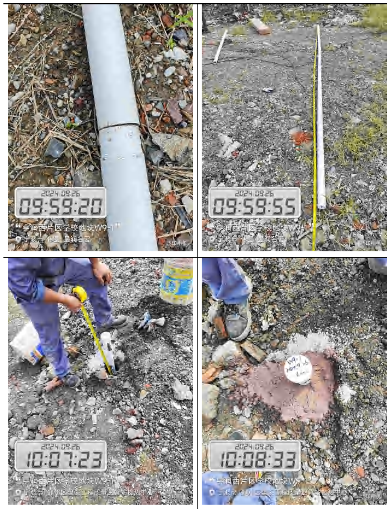
图 6.4-3 现场建井照片
