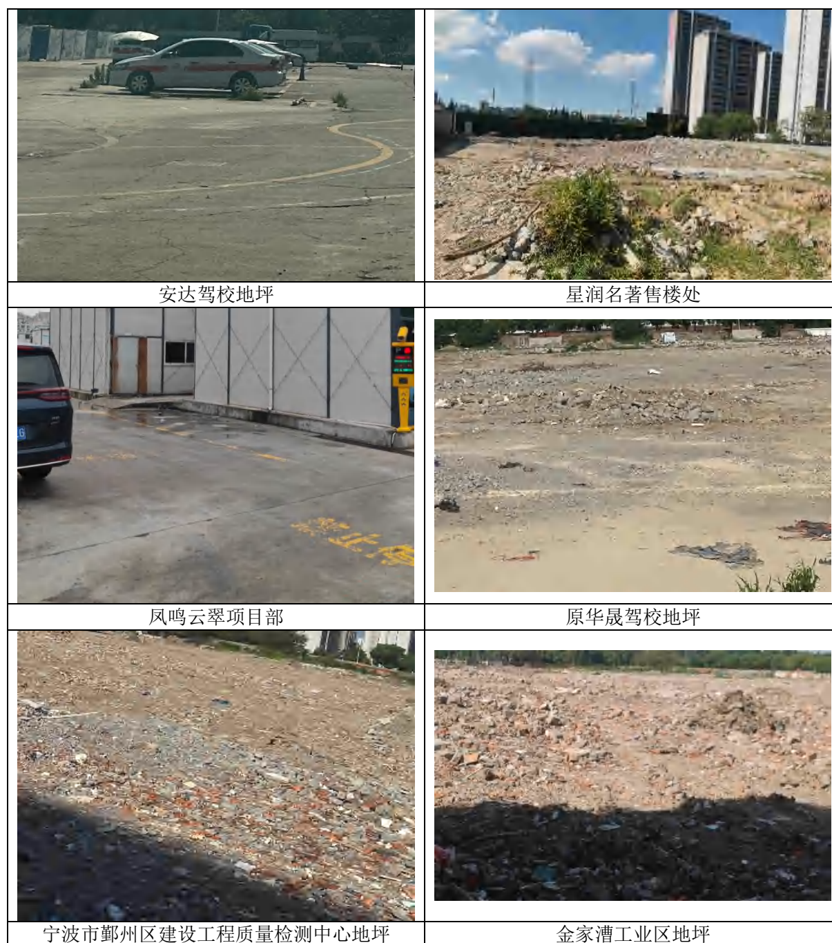
图 2.3-9 本地块现状地坪
