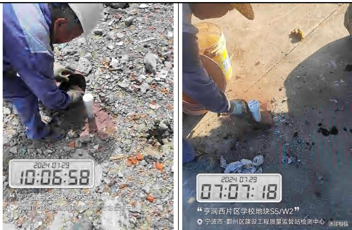
图 5.2-8 地下水监测井密封止水照片
