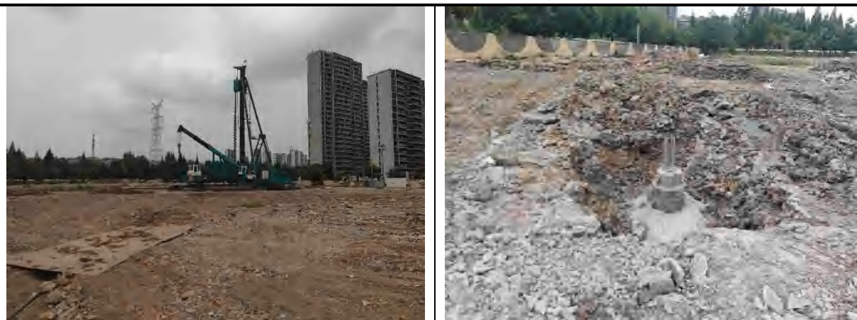
图 2.3-6 地块现状照片
