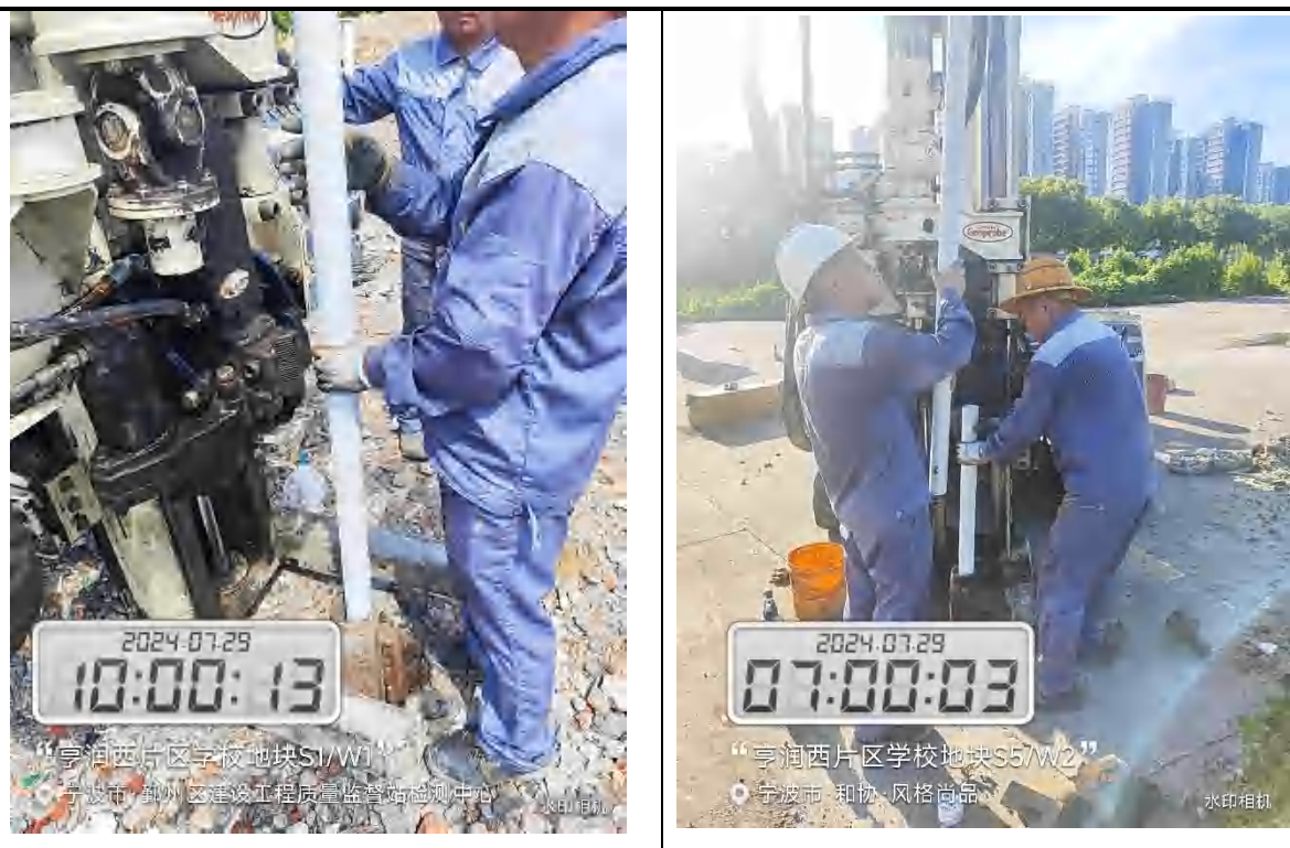
图 5.2-6 地下水监测井下管照片
