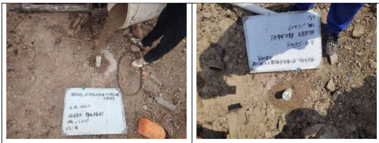
图 5.2-7 密封止水照片
