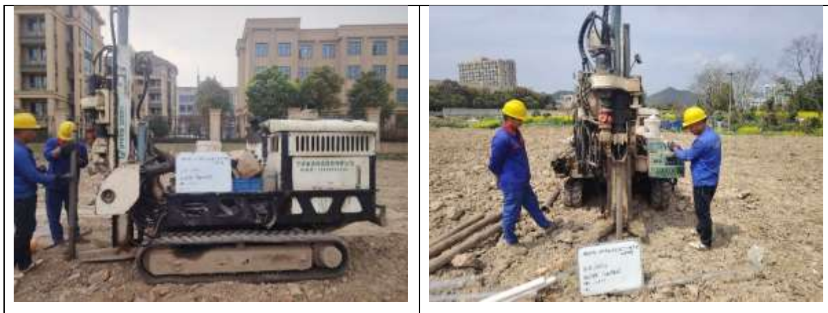
图 5.2-4 地下水监测井钻孔照片
