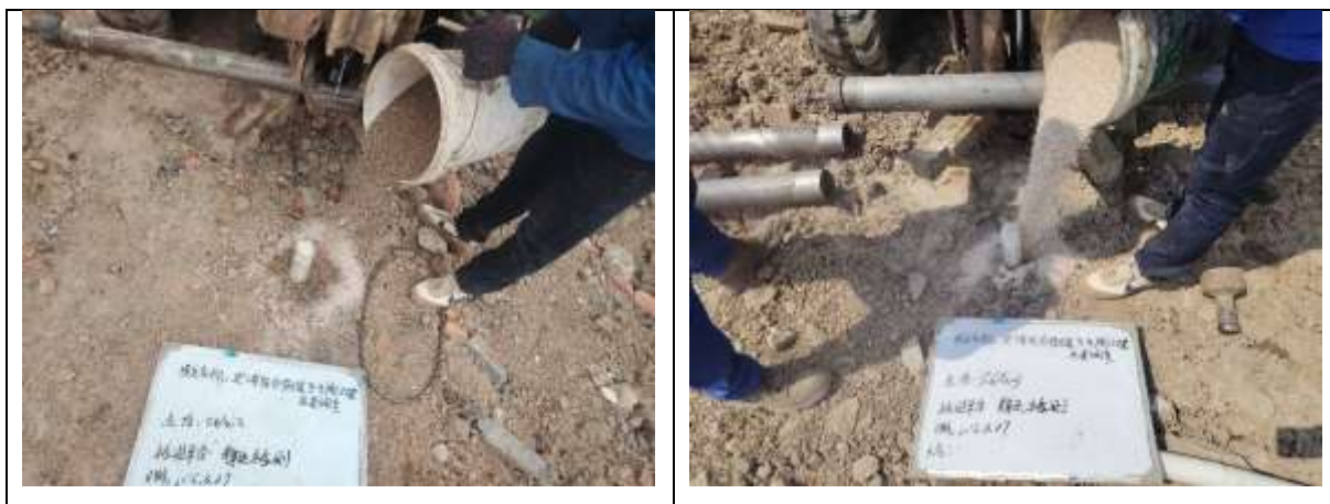
图 5.2-6 填充滤料照片
