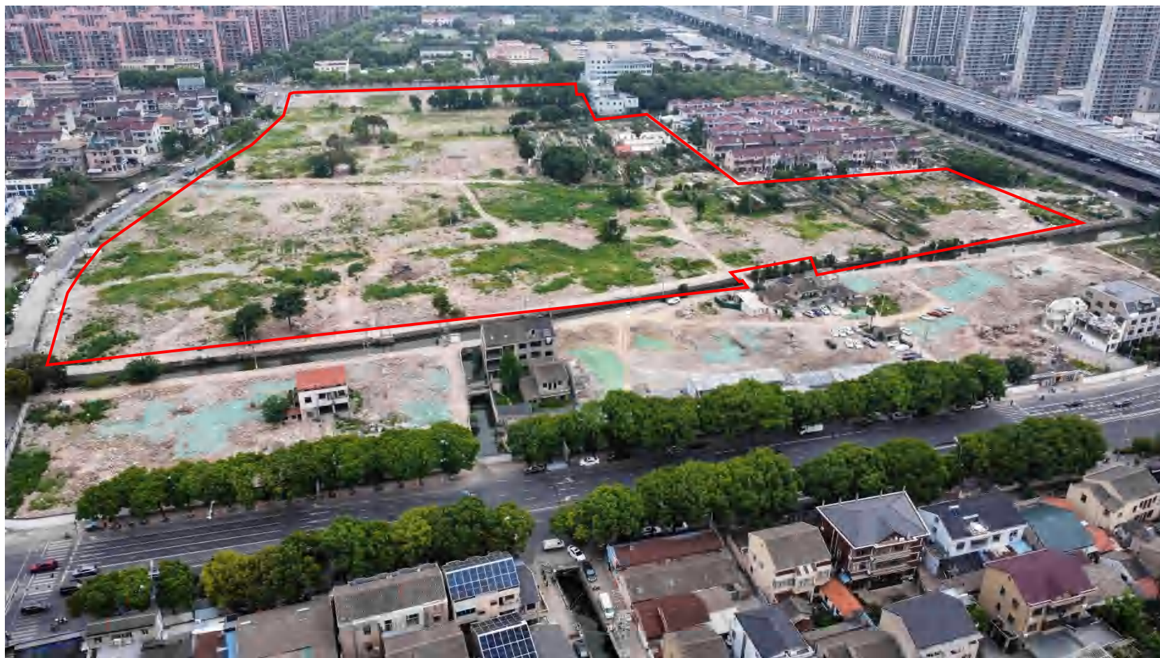
图 2.3-4 场地现状情况（无人机自南向北视角）
