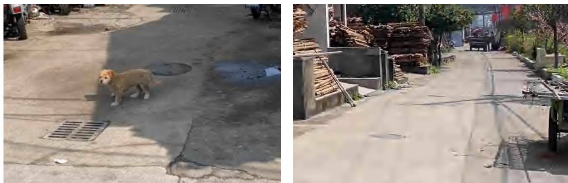
图 2.3-7 现场雨水及生活污水管道现场图
