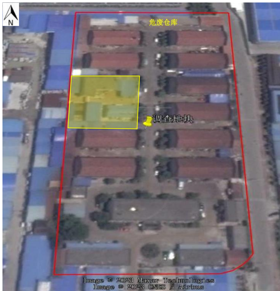
图 3.4-6 原废水处理区所在位置
