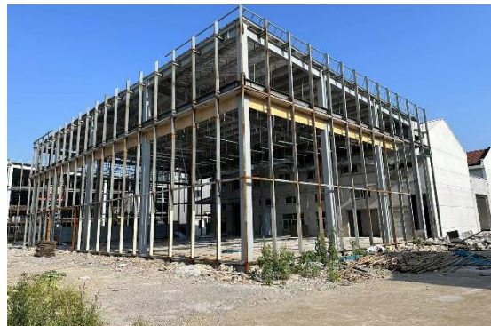
详调采样时，拆除内部钢结构（2024.8）
