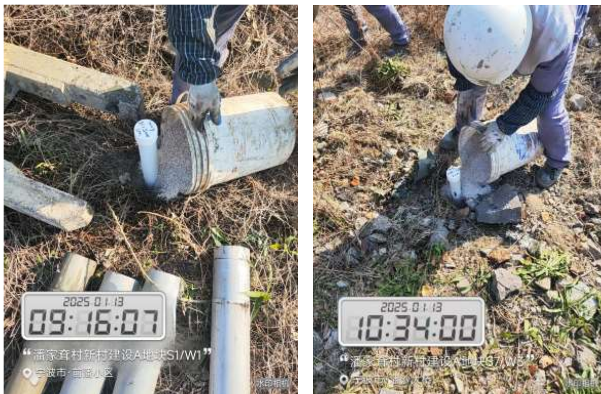
图 5.2-8 地下水监测井填充滤料照片
