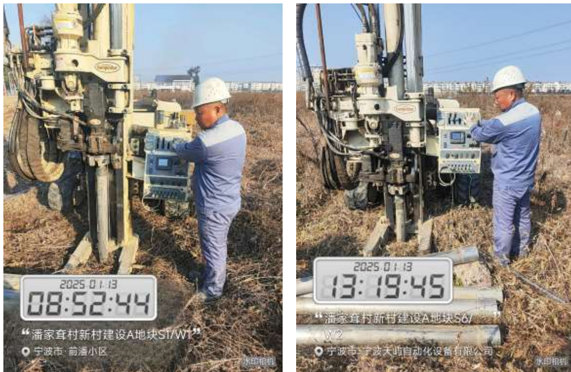
图 5.2-6 地下水监测井钻孔照片
