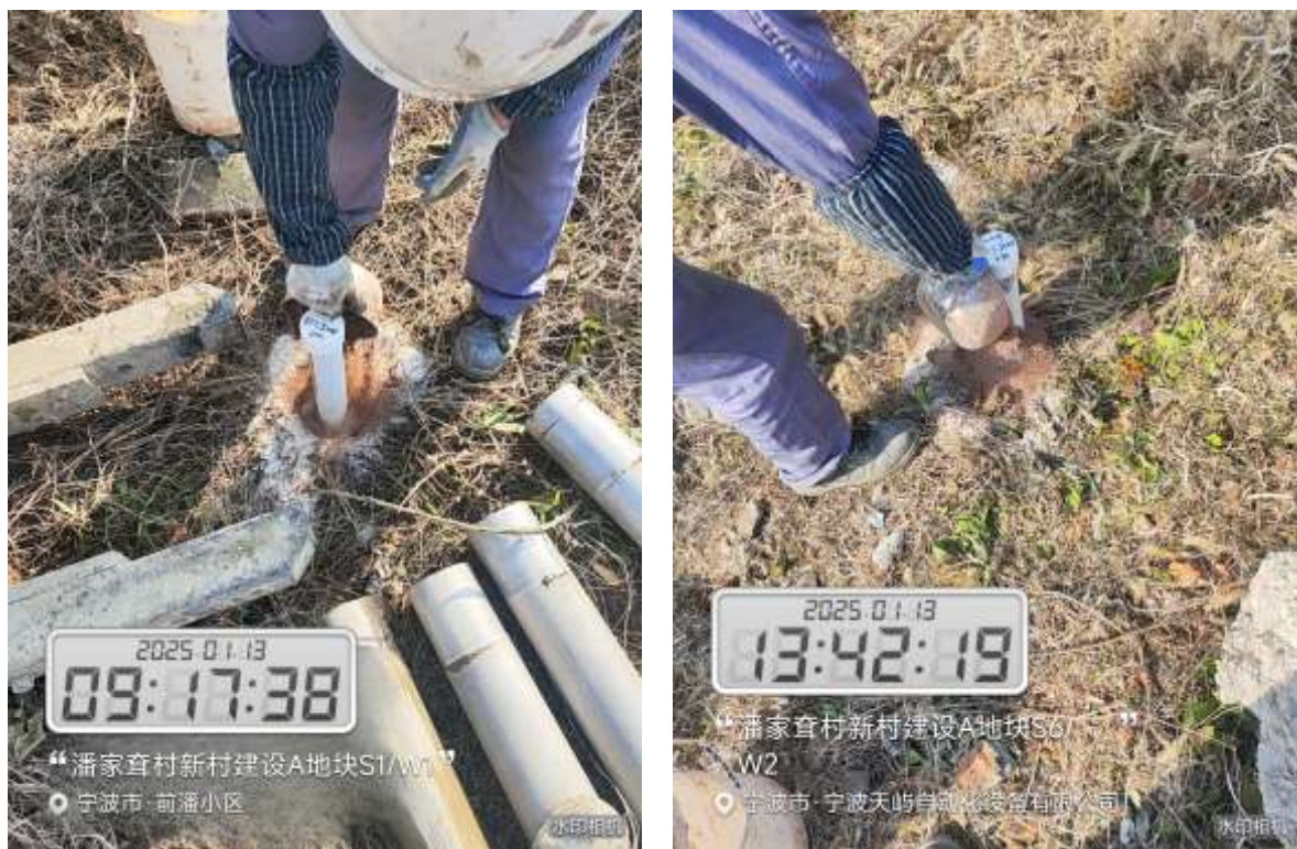
图 5.2-9 地下水监测井密封止水照片
