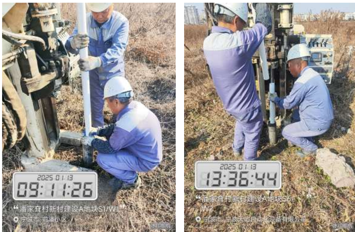
图 5.2-7 地下水监测井下管照片
